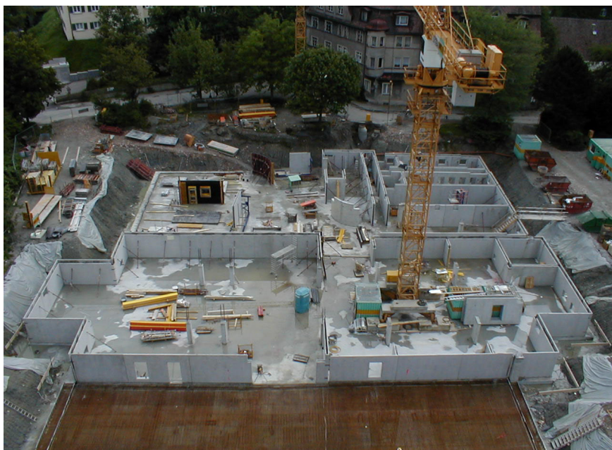
Weiße Wanne, ausgeführt mit Syspro-Doppelwänden – hier beim Neubau der Bodenseeklinik in Lindau, wo auf Grund der Seennähe stets mit drückendem Grundwasser zu rechnen ist.
